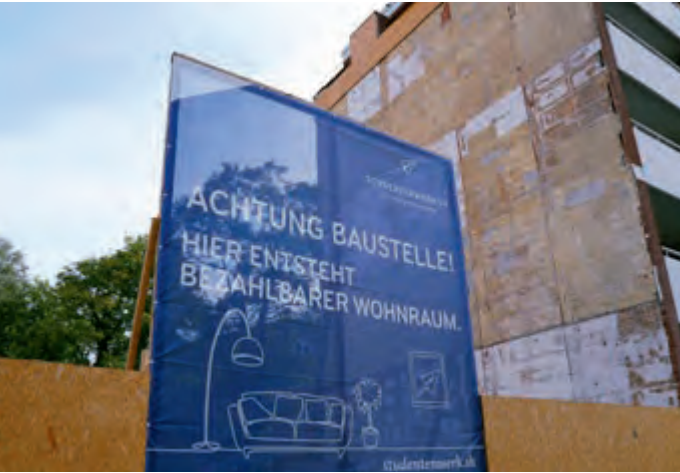
Eines von drei aktuellen Bauprojekten in Schleswig-Holstein: die Feldstraße 16 in Kiel.
