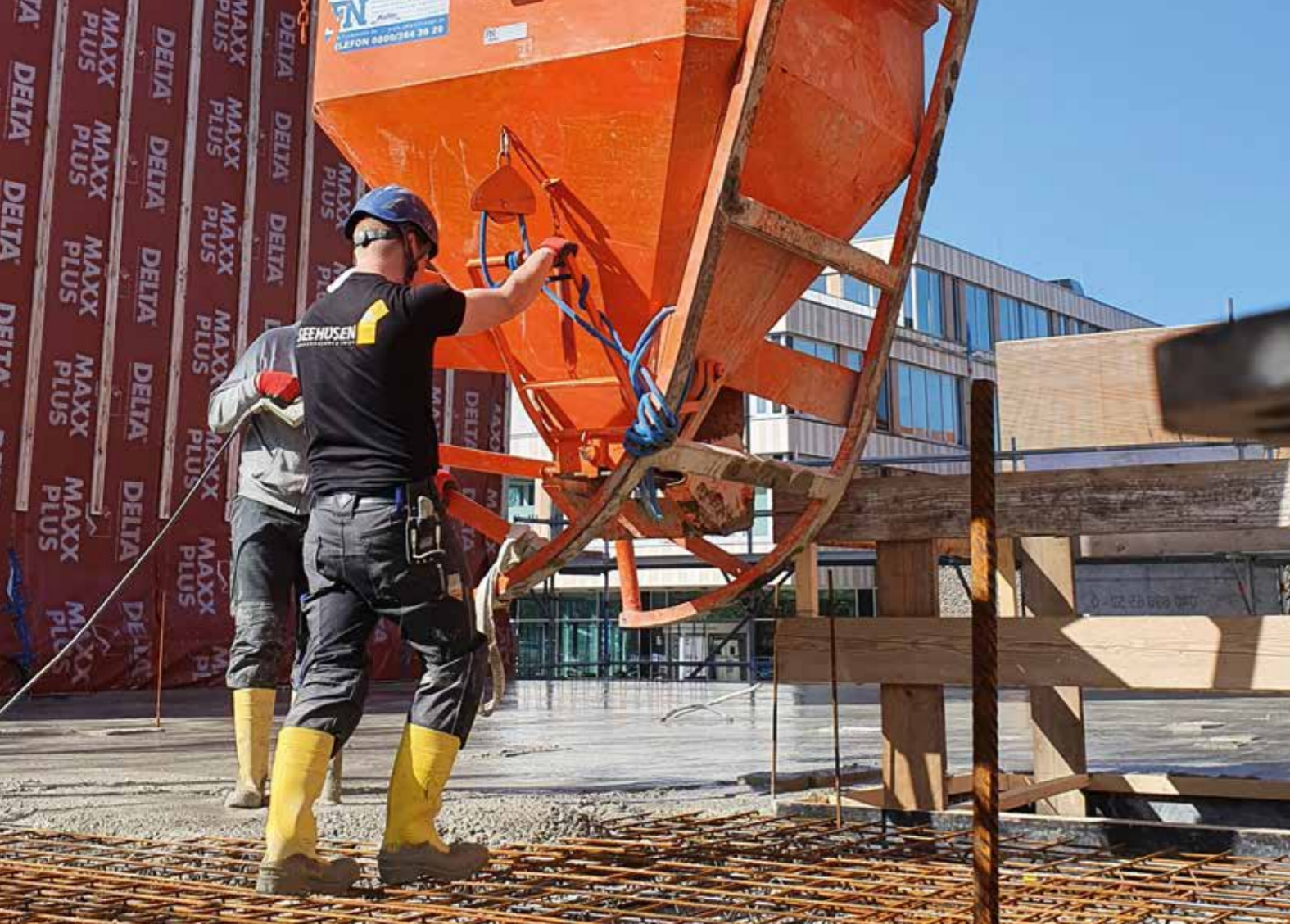
Auf allen Baustellen in Schleswig-Holstein geht es voran, unter anderem hier in der Feldstraße in Kiel.
