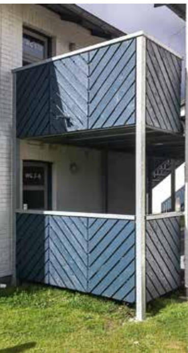
Das Haus Sandberg in Flensburg erhielt neue Balkone.
